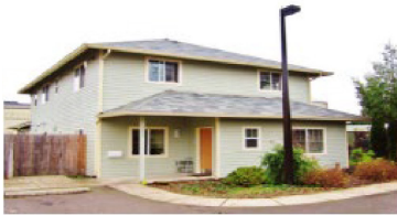
Mill Creek, casa para hombres
